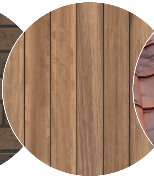
gemodificeerd houten gevelbekleding
